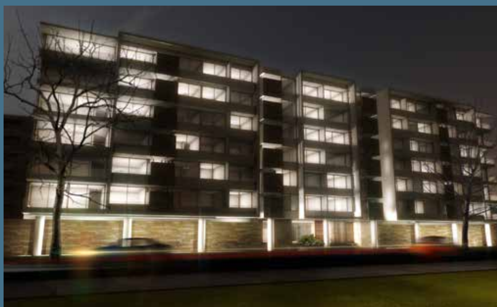
CONSTRUCCIÓN EDIFICIO MAYFLOWER
